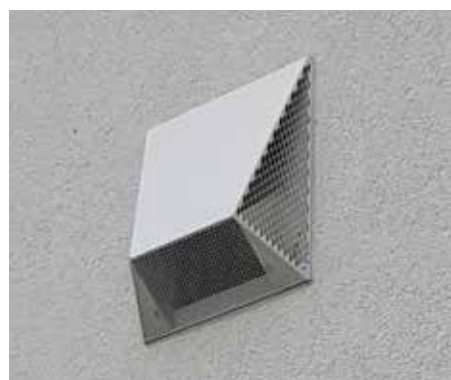
Élément de façade. (Photo: FHNW)
